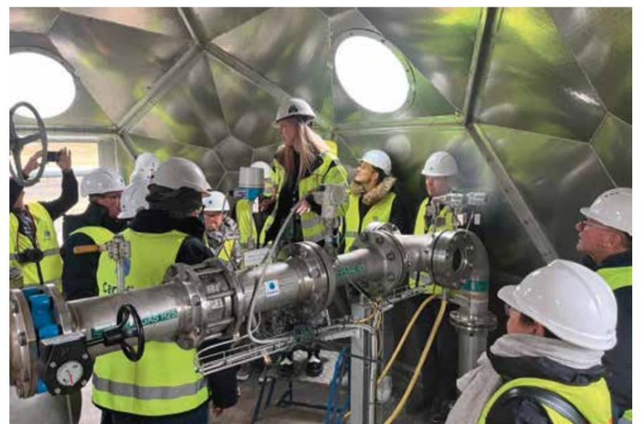
Im Reinjektionsbohrloch wird CO<sub>2</sub> aus der Luft vollständig in Basaltformationen injiziert und dauerhaft in Stein verwandelt.
